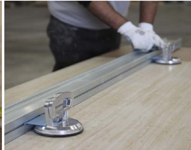
Iniciar el corte con rulina por el extremo de la pieza unos 2-5 cms
